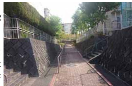
▲ 手すりやフェンスを樹木や植栽に変えれば、もっと、すてきな遊歩道になりそう!
